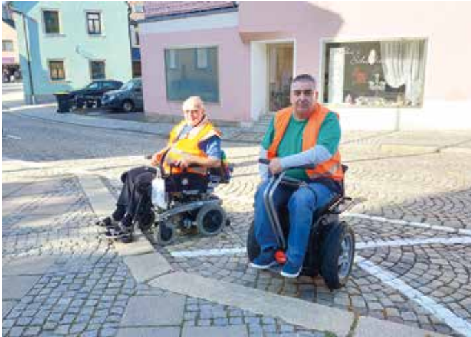
An dieser Kante in der Pfarrstraße ist die Weiterfahrt schwierig
